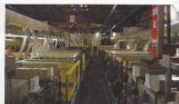
Site de traitements de surfaces, Saint-Nicolas-de-Redon.
